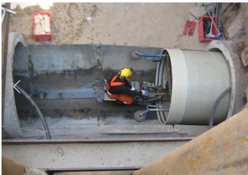
Wprowadzanie modułów GRP do wnętrza kanału
