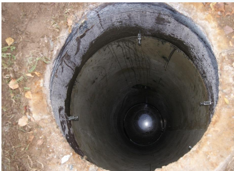
Studzienka kanalizacyjna po zamontowaniu wkładów GRP, przed laminowaniem
