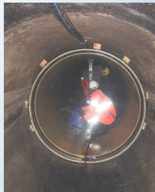
Montaż paneli GRP we wnętrzu odnawianego kanału
