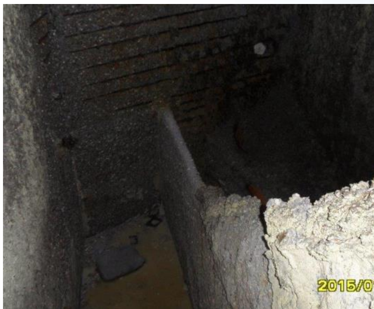
Komora kanalizacyjna przed renowacją
