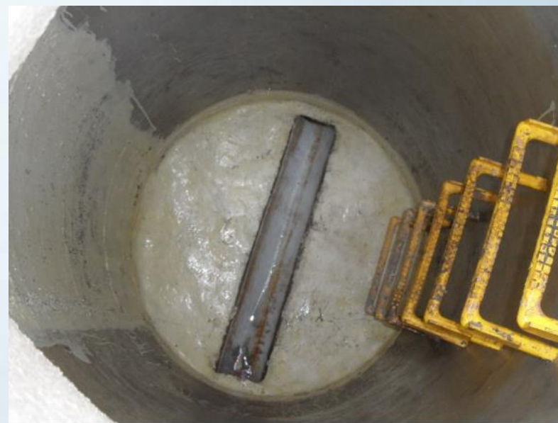
Studzienka kanalizacyjna po zamontowaniu wkładów GRP, po laminowaniu
