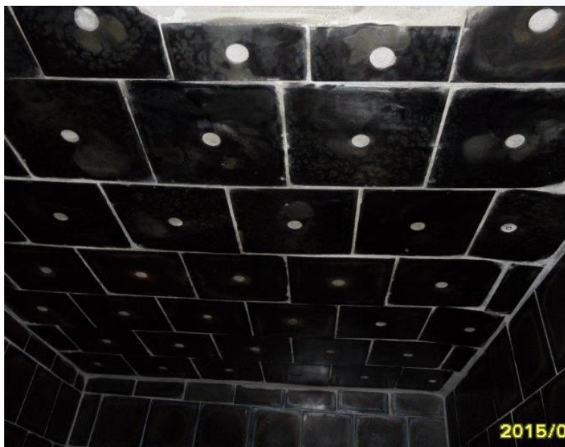
Komora kanalizacyjna po renowacji
