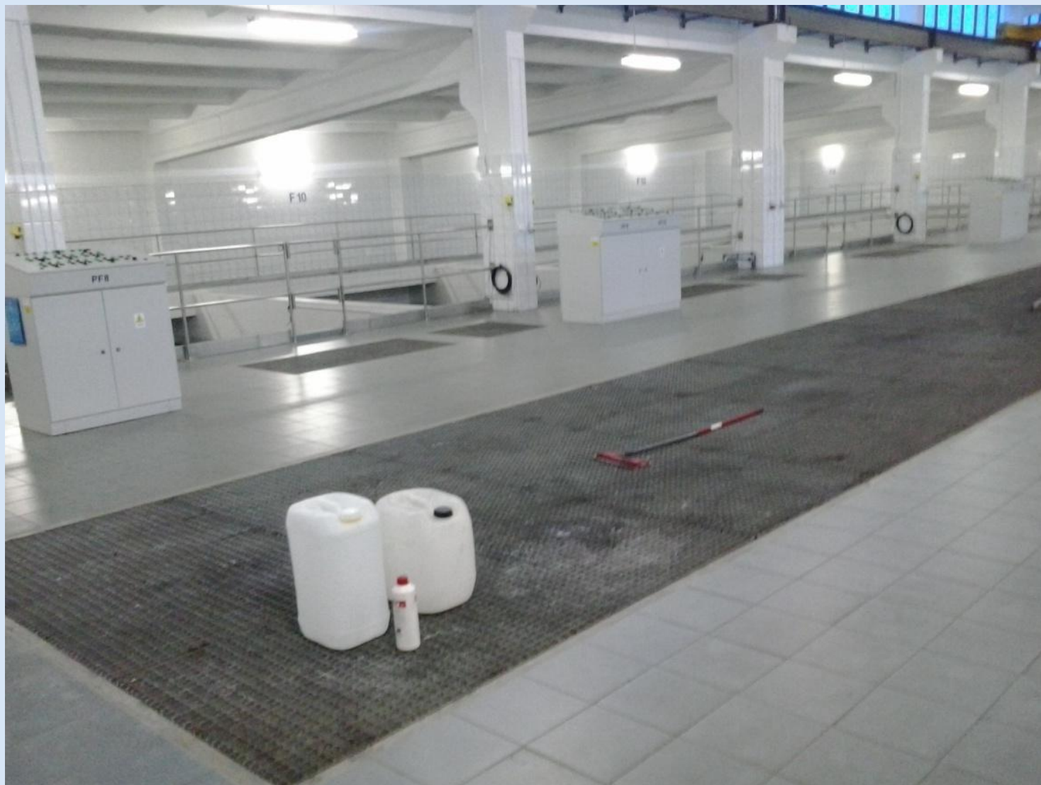
Fragment hali filtrów węglowych biologicznie aktywnych – filtry II°
