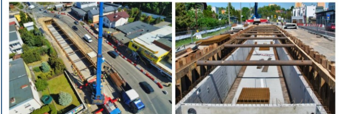
Zbiornik retencyjny w ulicy św. Maksymiliana Kolbego w Bydgoszczy o pojemności ok 550 m 3 . To jeden z 71 zamkniętych zbiorników, które powstaną na terenie Bydgoszczy w ramach projektu „Budowa i przebudowa kanalizacji deszczowej i dostosowanie sieci kanalizacji deszczowej do zmian klimatycznych, na terenie miasta Bydgoszczy” współfinansowanego ze środków unijnych.
