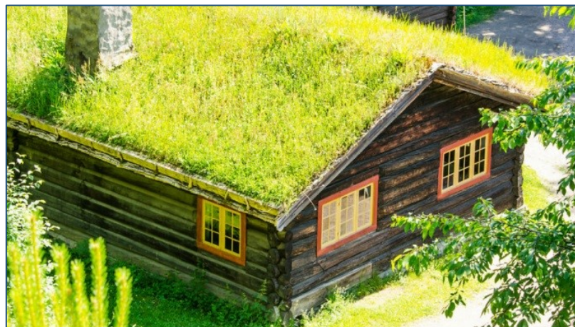
na zielonych dachach
