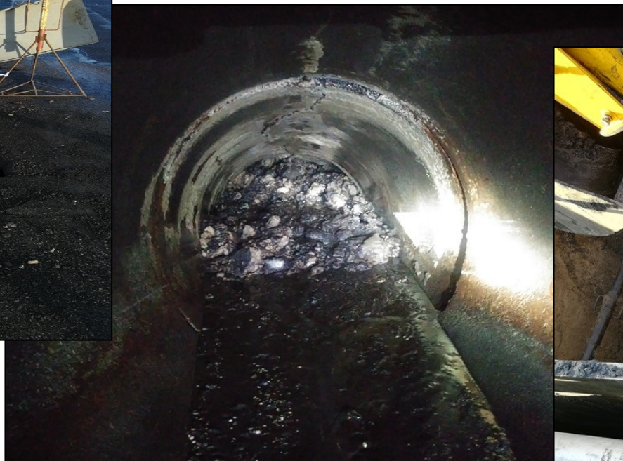
ul. Nikłowa – zapadnięcie kanału na odcinku 230mb.
