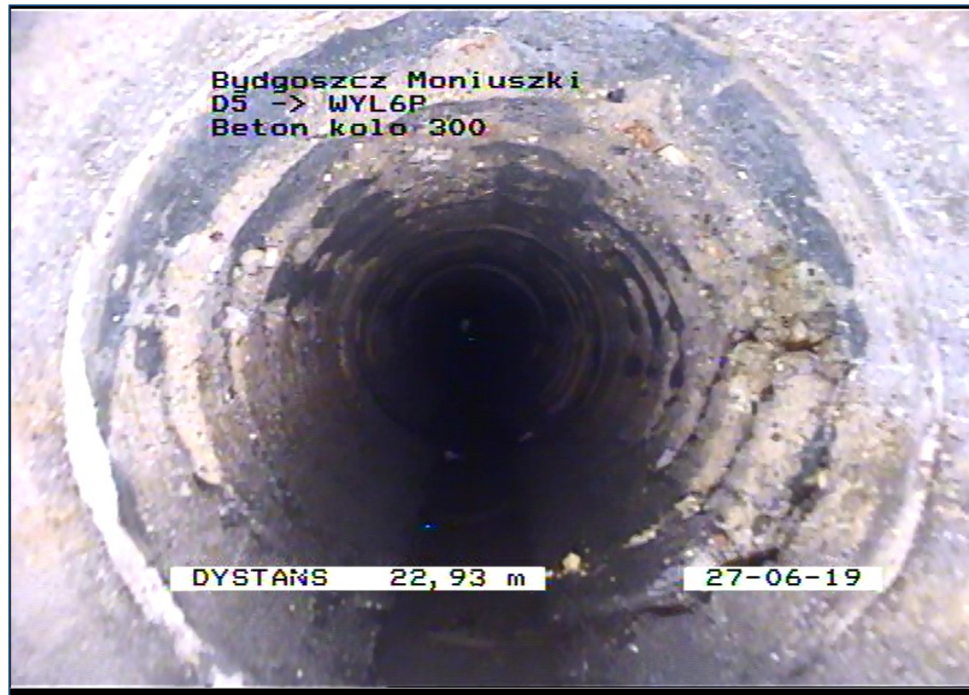
ul. Moniuszki - znaczne uszkodzenia kanału i kanał po renowacji
