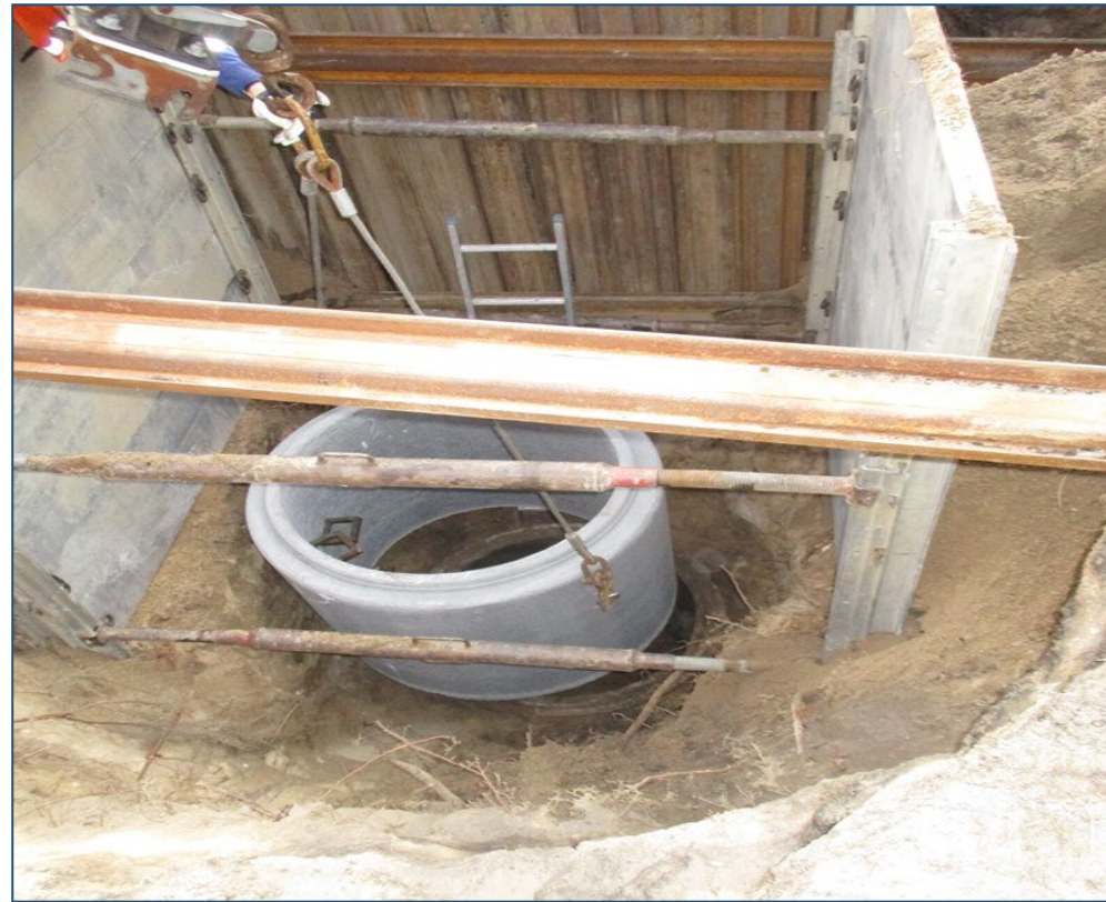
ul. Techników - lokalizacja studni a później jej wybudowanie
