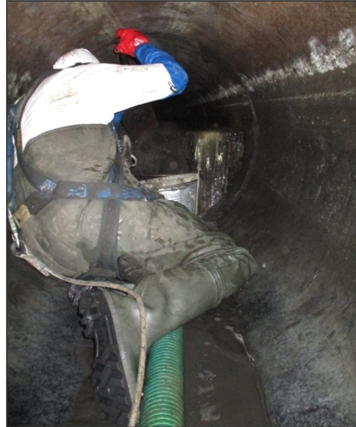
ul. Andersa - prace w kanale oraz stan zanieczyszczenia
