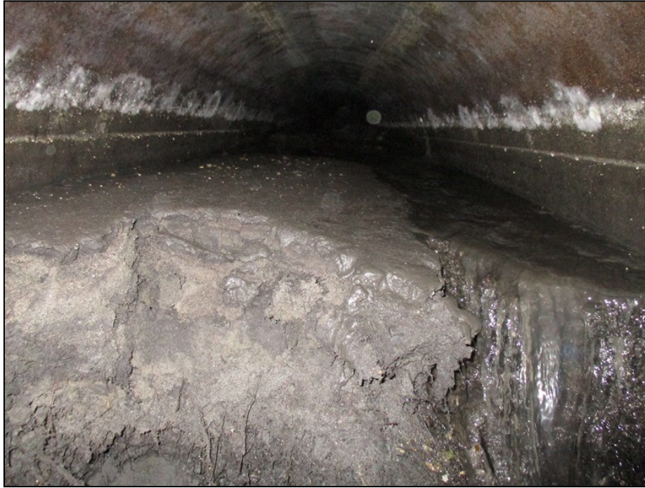
ul. Andersa - prace w kanale oraz stan zanieczyszczenia
