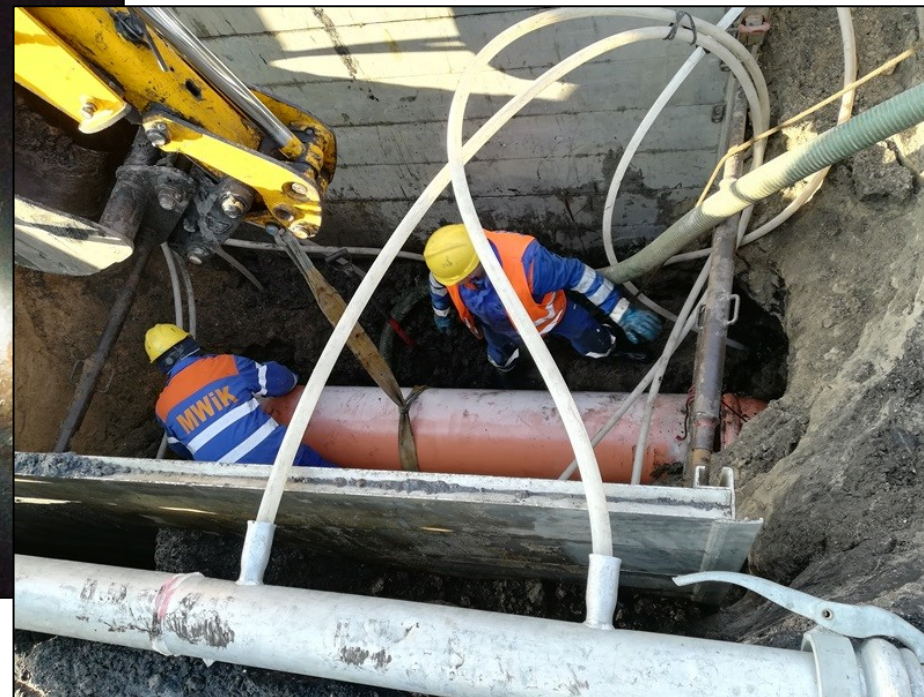
ul. Nikłowa – zapadnięcie kanału na odcinku 230mb.
