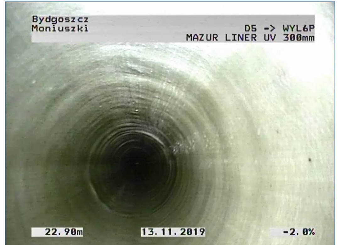
ul. Moniuszki - znaczne uszkodzenia kanału i kanał po renowacji
