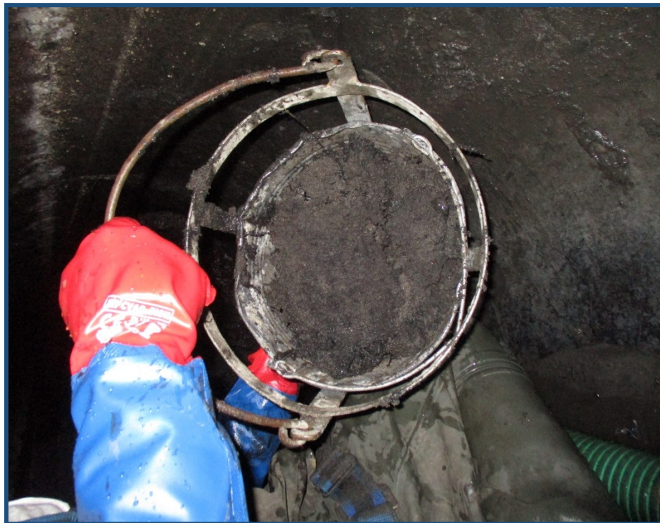
ul. Andersa – transport urobku ze studni po czyszczeniu
