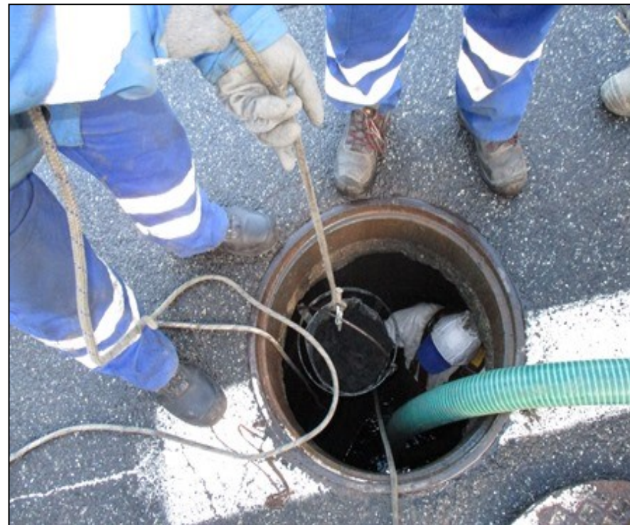
ul. Andersa – transport urobku ze studni po czyszczeniu
